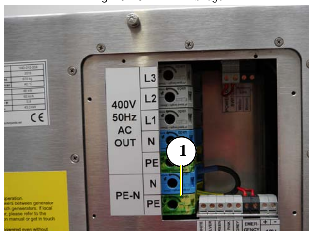
Fig. 10.7.3.1-1: PE-N bridge
